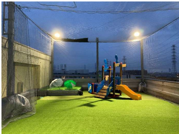
＜屋上人工芝施設＞
